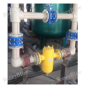
多介质过滤器(滤床),既采用两种以上的介质作为滤层的介质过滤器。在工业循环水处理系统中,用以去除污水中杂质、吸附油等,使水质符合循环使用的要求。过滤的作用主要是去除水中的悬浮或胶态杂质,特别是能有效地去除沉淀技术不能去除的微小粒子和细菌等,对BOD和COD等也有某种程度的去除效果。多介质过滤器主要由过滤器体、配套管线和阀门构成。其中过滤器体主要包括以下组件:简体;布水组件;支撑组件;反洗气管;滤料;排气阀(外置)等。
